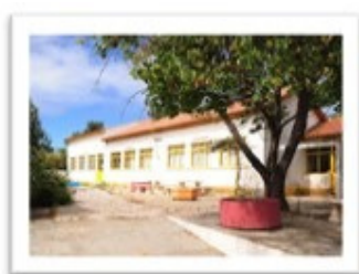
7 - EB1 da Fonte Santa nº2
